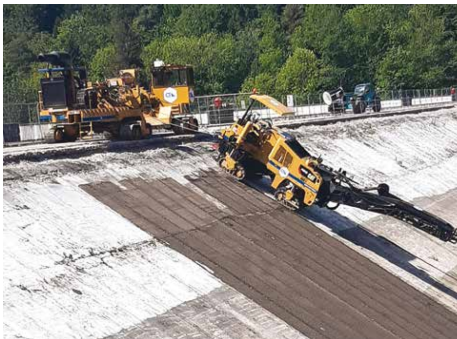
3. Grazie a una cilindrata e a una coppia superiori alle frese dello stesso segmento, la Serie PM300 può lavorare su pendenze fino a 35°
