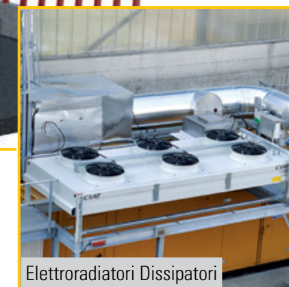
Skid recupero termico
